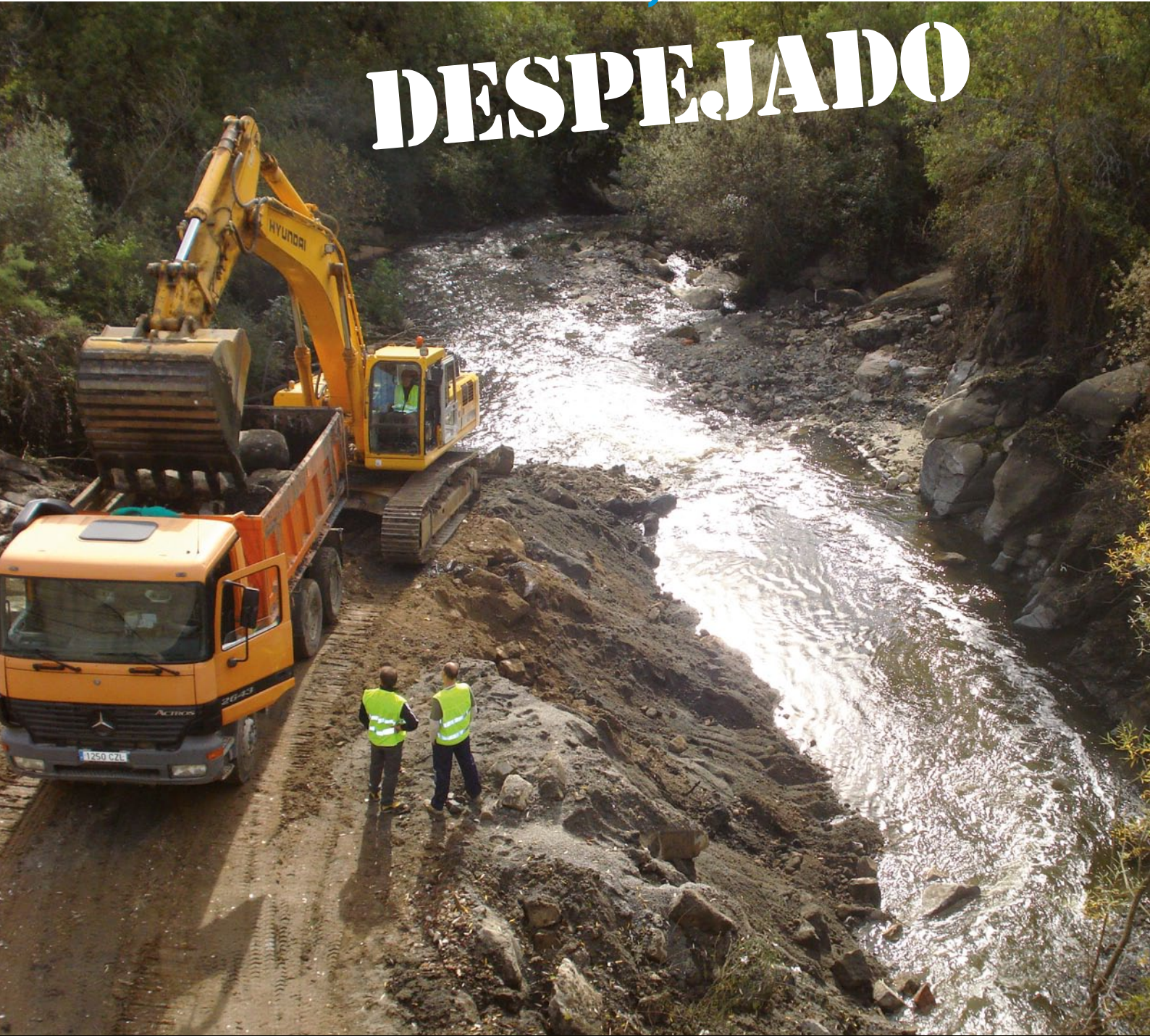
Trabajos de demolición del azud sobre el Guadarrama.
